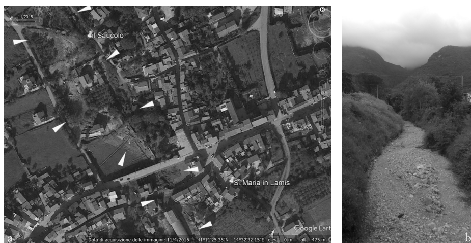
Fig. 8a-b. Nella ripresa da satellite del 4 novembre 2015 per lo stesso settore della mappa d'impianto (Fig. 7) sono evidenti i segni lasciati dalla piena del Saucolo (freccie bianche) rispetto all'edificato (foto: Google Earth). A fianco, lo stesso alveo prossimo a divenire "pensile" in quanto ostruito dai detriti, nel punto in cui sull'immagine a) è posta l'indicazione del nome del torrente.
